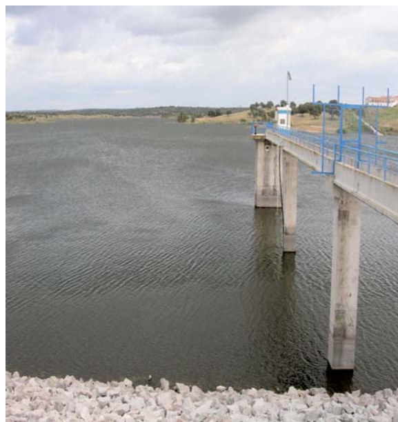
Figura 7. Rio Enxóe, barragem para abastecimento de água no Alentejo, Portugal
